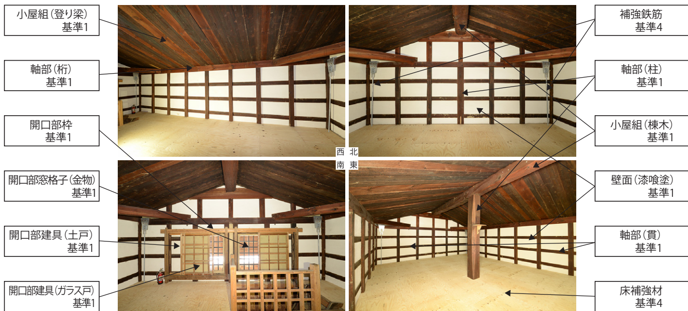
土蔵 三階蔵3階内部
