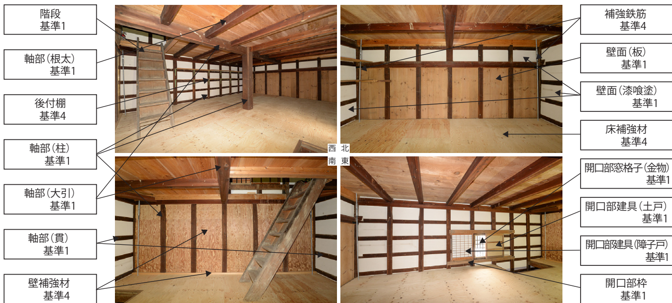
土蔵 三階蔵2階内部
