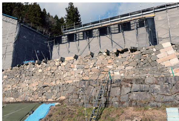
写真 4-1 修理を終えた主屋前面石垣
