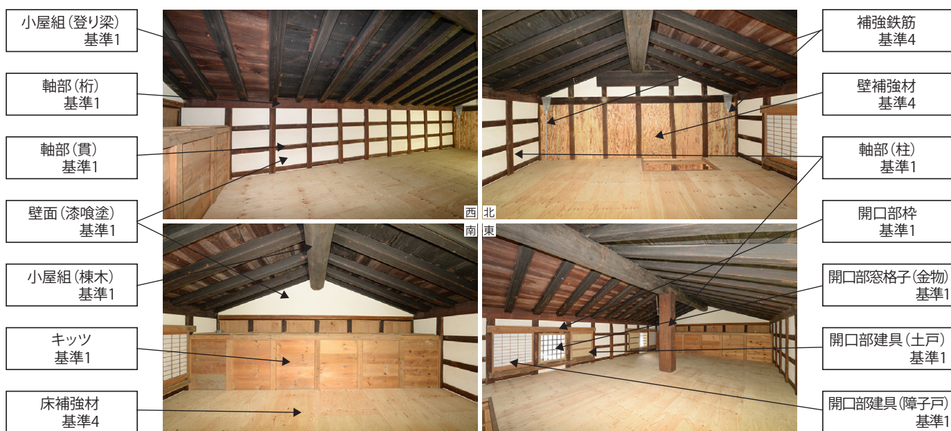
土蔵 二階蔵2階内部
