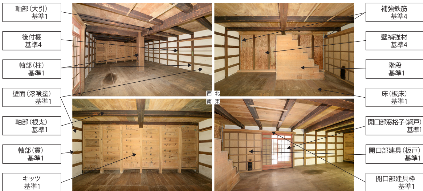
土蔵 二階蔵1階内部
