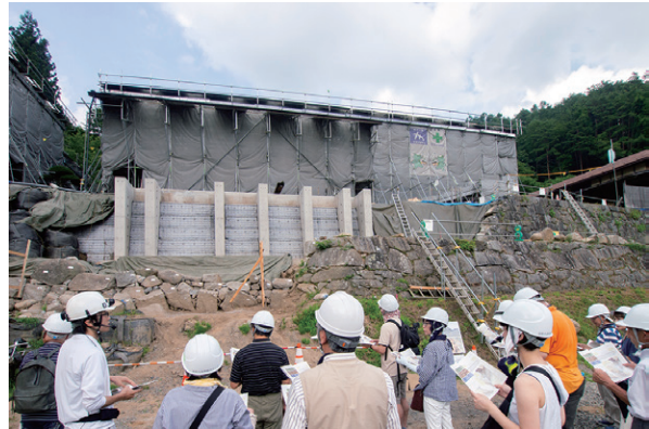
写真 2-14 修理工事見学会
