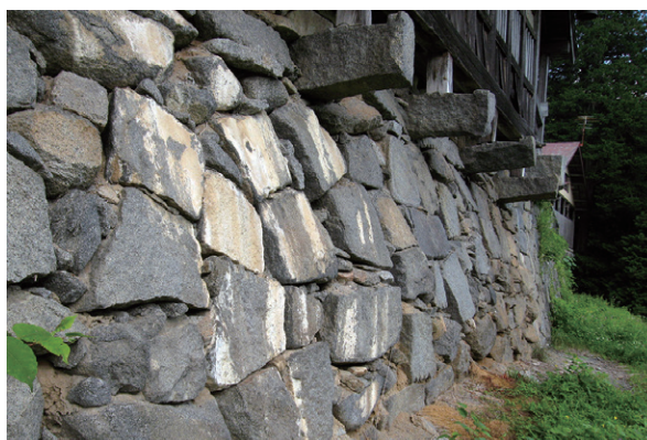
写真 2-2 主屋直下の石垣の積み出し
