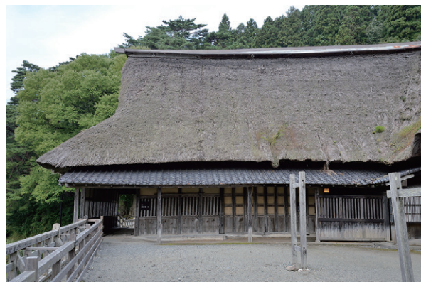
写真 1-3 馬屋 左側三間が増築部分（修理前）
