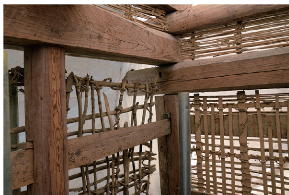
写真 1-15 大工小屋の三種類の壁下地 (修理中)
