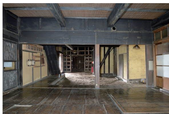
写真 1-9 ダイドコロから馬屋を見る（修理前）
