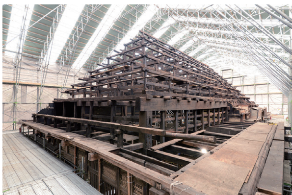
写真 1-4 本屋の小屋組（修理中）
