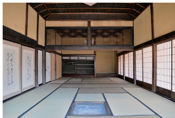
写真 1-7 イリザシキとオクザシキ（修理前）
