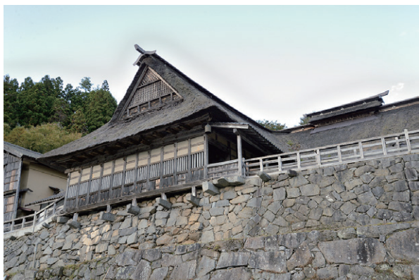
写真 1-2 石垣から迫り出す馬屋（修理前）
