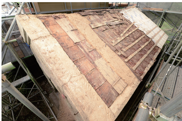
写真 1-12 石蔵の屋根 (修理中)
