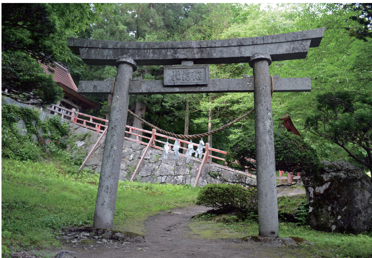
写真 1-1 鳥居現況写真
