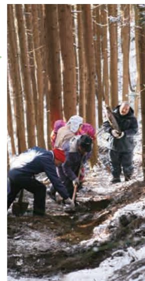
②老朽化していた階段の整備
