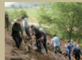
上_階段を取り外し斜面をなだらかに 左上_鳥居の基礎を作り直し 左_橋板も頑丈なものに取替え
