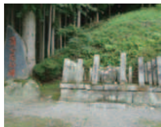
改修前。囲いも古くなっていました。
