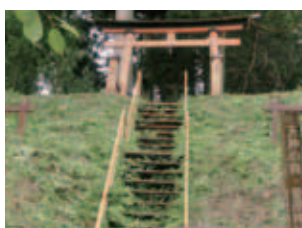
左_階段は鉄板がさび、坂も急で登りづらいです 左下_階段手前の橋には穴が…とても危険！ 下_鳥居の基礎もぼろぼろ。早急に直す必要があります
