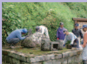
まずは解体作業から。柵を外して、みんなで作業工程を模索しています
