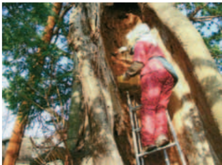
腐朽した部分を除去し、防腐剤を塗布
