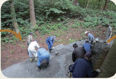
② 凹凸の酷い箇所を砂利で埋めます
