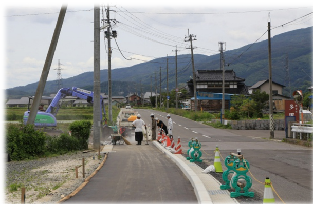
《歩行者の安全確保に向けた歩道整備》
