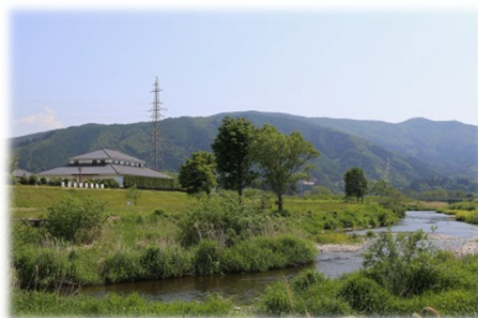
《浄化センターと早瀬川》
