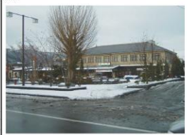
街並みの統一が図られていない商店街
