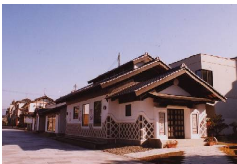
下一日市地区に整備された地ビールレストラン。この施設のほか3つの建物が蔵を活用した建物である。
