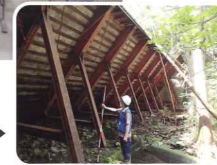
▶治山施設の点検
