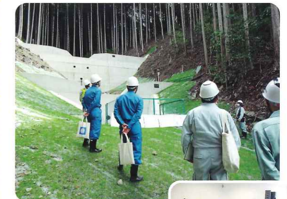
▲消防・警察と連携した治山施設パトロール
