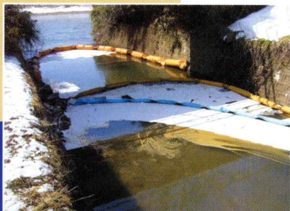
油の回収作業の様子
