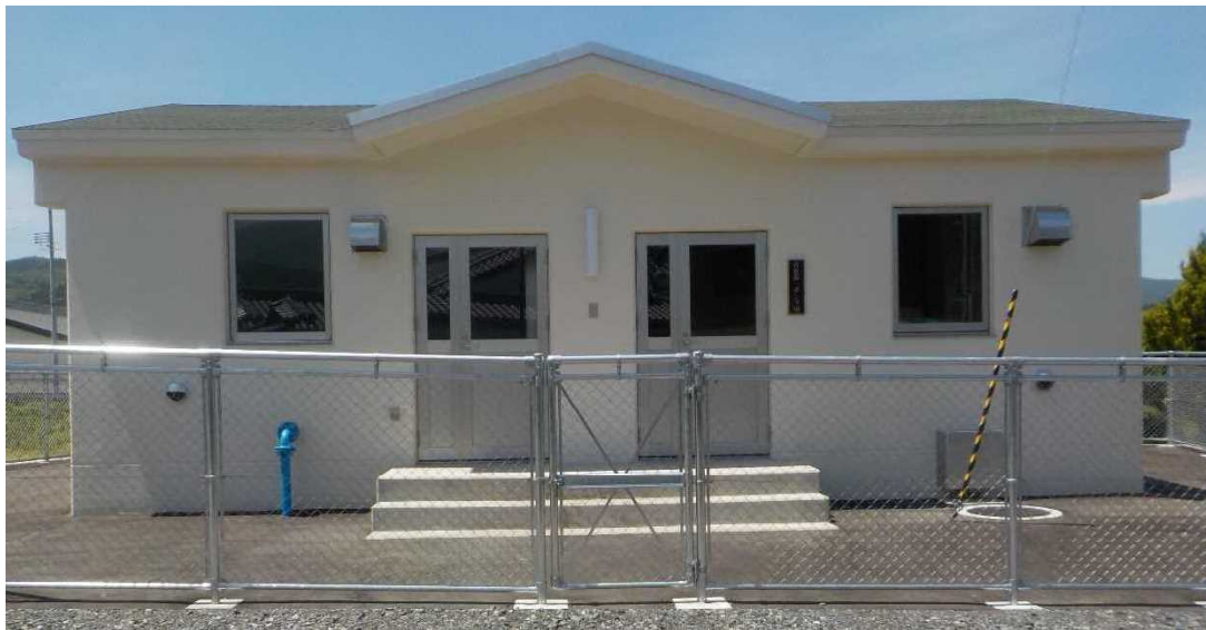
【青笹第1ポンプ場】
