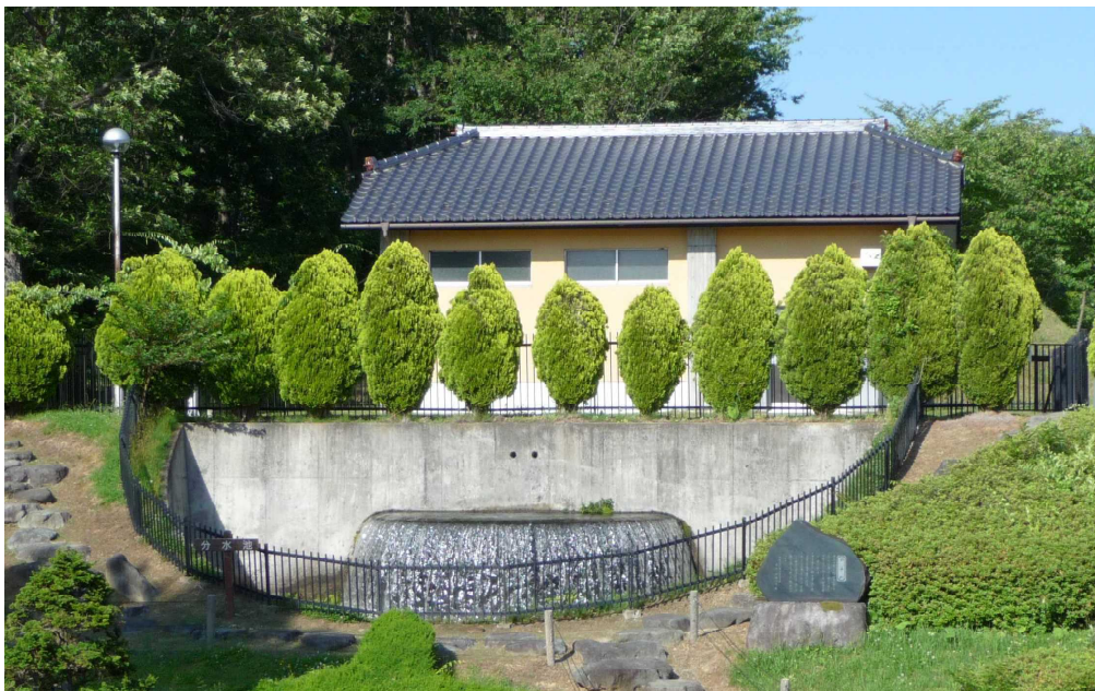
【高室浄水場 分水槽】
