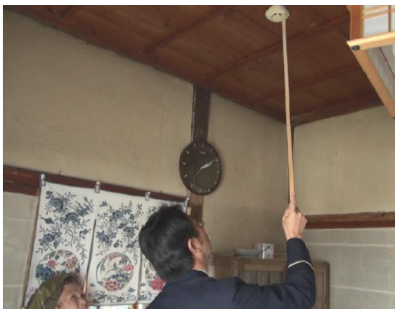
住宅用火災警報器設置状況及び維持管理調査
