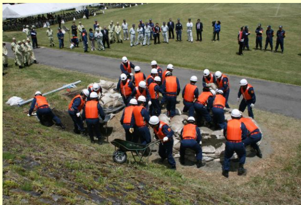
水防工法訓練(釜段工)の様子
