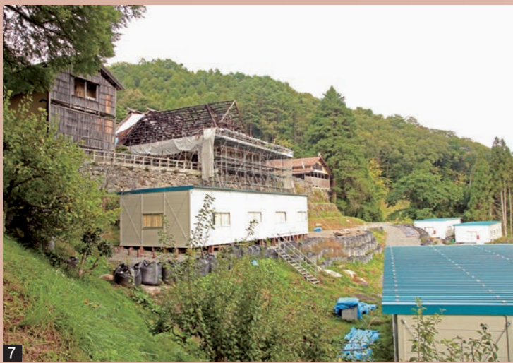
7_ 工事中の千葉家 8_ 9_ 建材は、解体前に番号をふり、後で復元できるように記録。現地の保存小屋に保管します 10_ 旧綾織小体育館には、千葉家の家財道具などが一時保管され、整理・修繕作業が行なわれています
