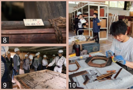
7_ 工事中の千葉家 8_ 9_ 建材は、解体前に番号をふり、後で復元できるように記録。現地の保存小屋に保管します 10_ 旧綾織小体育館には、千葉家の家財道具などが一時保管され、整理・修繕作業が行なわれています
