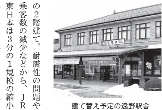
建て替え予定の遠野駅舎
