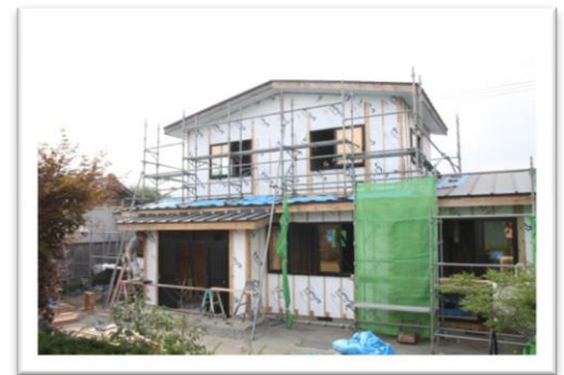
被災住宅の改修工事を補助
