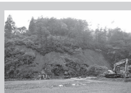
土砂崩れが発生した宮守町達首部の湯屋地区
