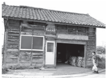
古い倉庫を活用した回収所
