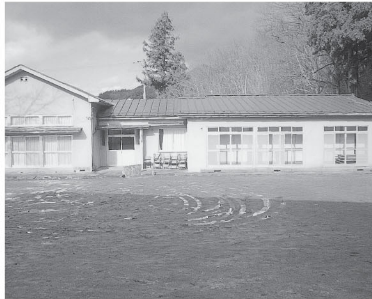
老朽化により、新たな拠点施設の整備が求められている老人憩いの家
