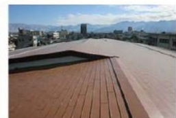
耐久性に優れた屋根材の一例（カラーガルバリウム鋼板）
