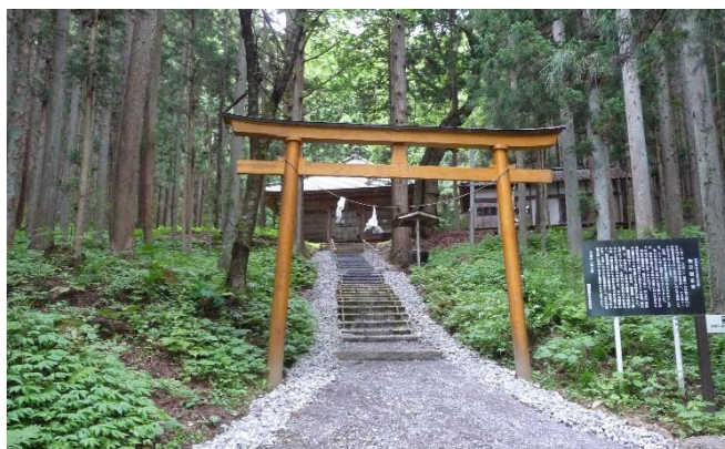
↑ 補修工事完了後の白山神社
