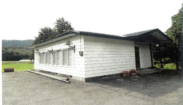
大川目地区集会所（4区）外壁塗装
