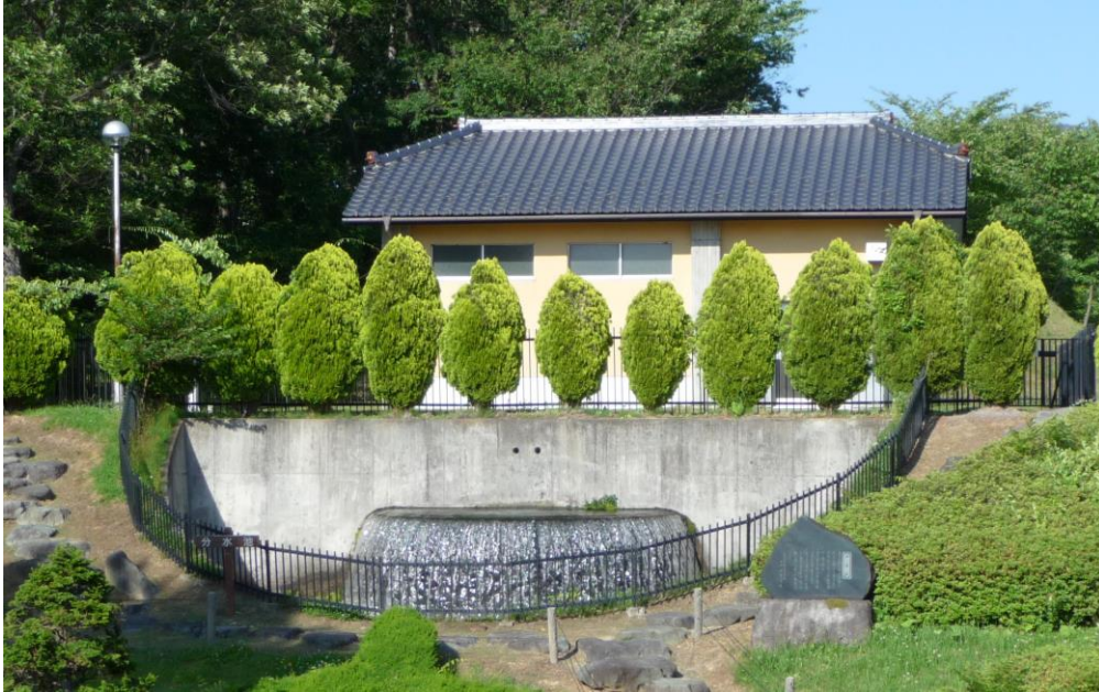
【高室浄水場 分水槽】
