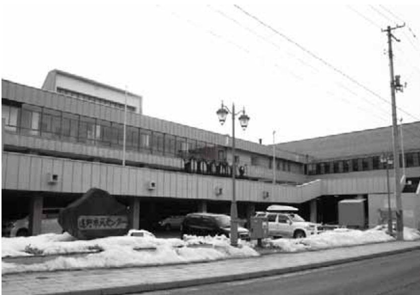
改修予定の遠野市民センター
