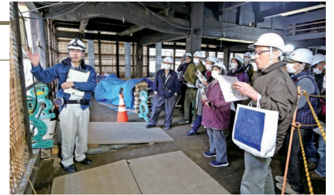
工事担当者から修理状況の解説を聞く
