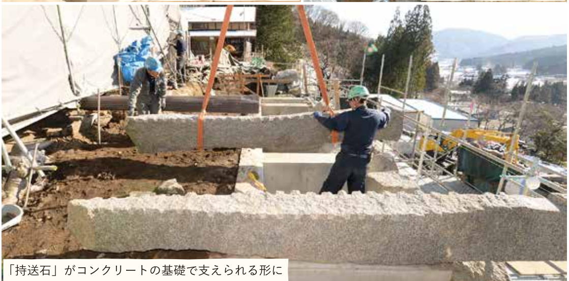
石垣の負担を減らすため コンクリートの補強基礎を設置
