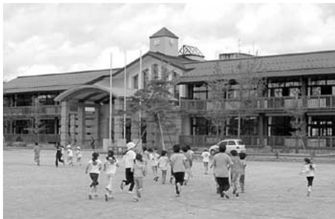
地場産材をふんだんに使用し完成した上郷小学校
