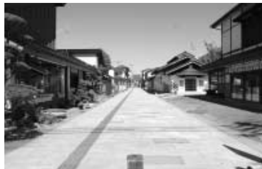
歴史的に貴重な建築物の保全と活用を図りながら、遠野らしい街並みが形成された下一日市区画整理事業
