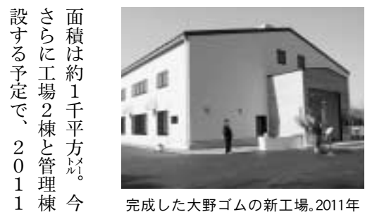
完成した大野ゴムの新工場。2011年度の完成を目指し、同敷地内にさらに3棟が増設される
