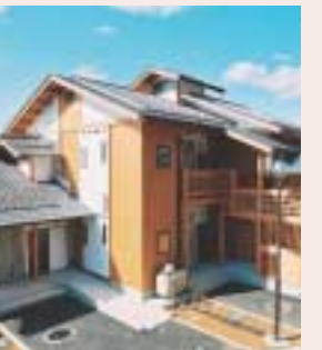
大断面集成材パネル工法で作られた県営鳴石アパート
